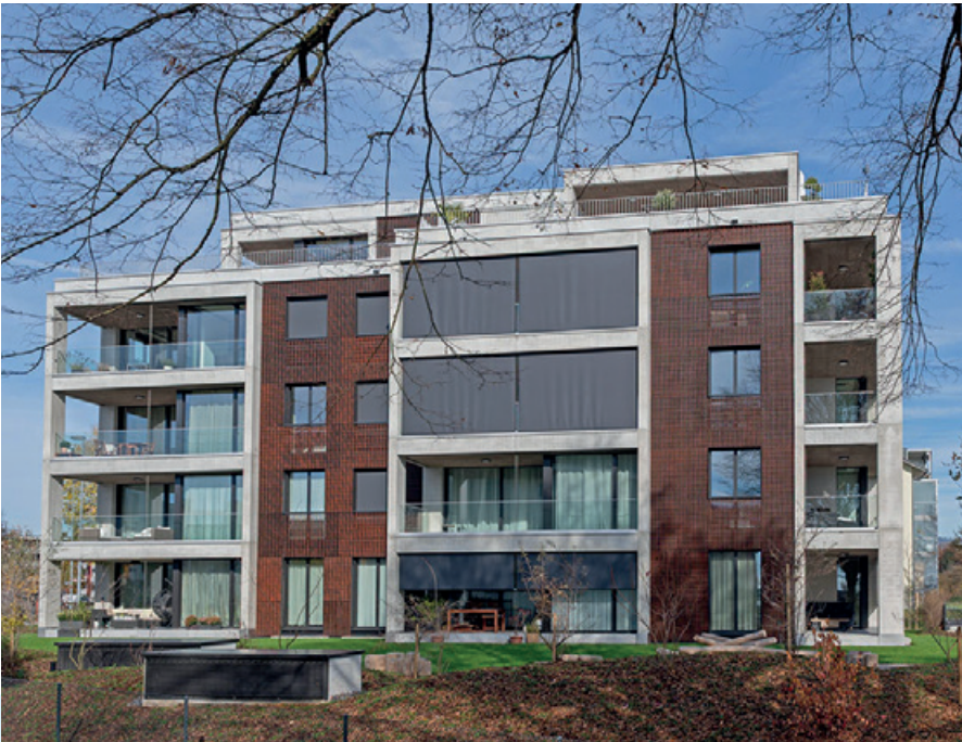
Das Mehrfamilienhaus präsentiert sich heute in voller Pracht und die Fassadenelemente aus rostenden Armierungseisen integrieren sich ausgezeichnet im Gesamtbild.
